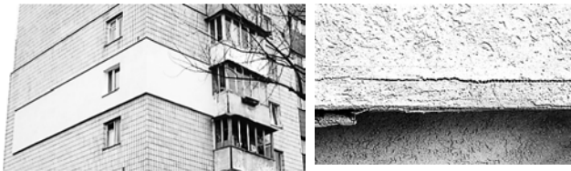
а) зовнішній вигляд фасаду б) стан утеплювача в процесі експлуатації
