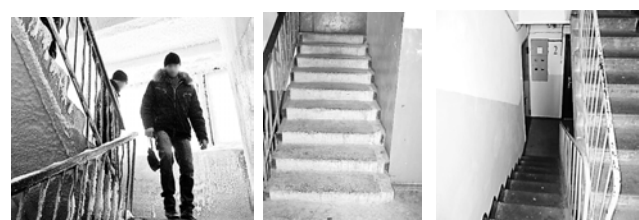
Рис. 10. Вид стін всередині під'їзду до і після ремонту та утеплення
