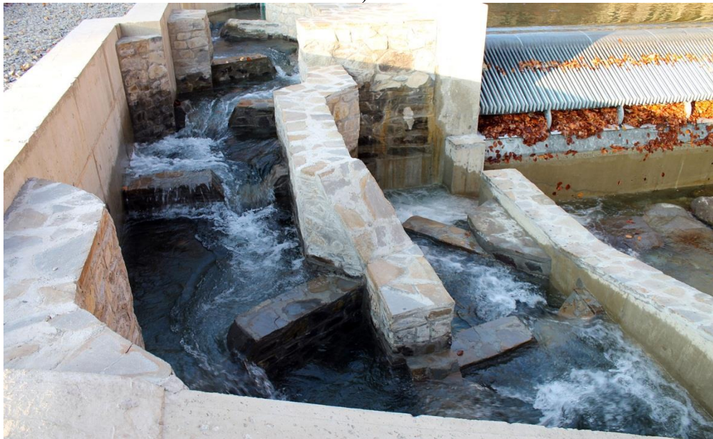
Рис.1. Тур'я-Полянська мала ГЕС (Шипот-2): а) будівля, в якій знаходиться турбіна; б) рибохід і на водозаборті та решітка через яку відбирається вода із водотоку[5].
