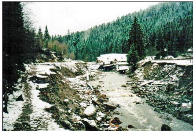
Рис. 2.26. Наслідки повені 1998 року. Залишки греблі, руйнація берегів ріки, немає моста, жалюгідні залишки автомобільної дороги. Фото через декілька днів після повені. Фото з архіву НПП «Синевир». 1998 р.
