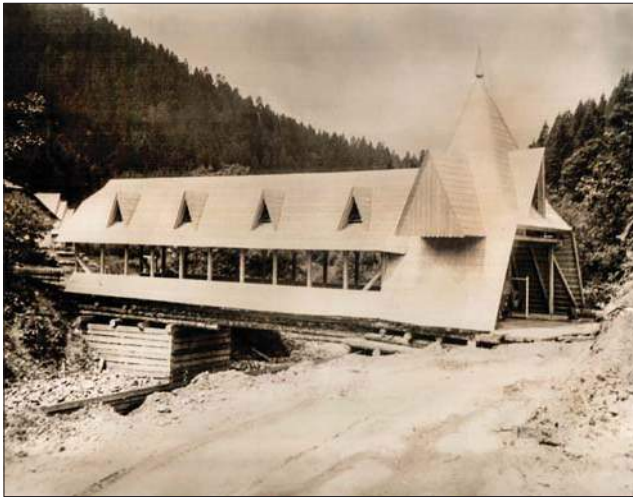
Рис. 2.24. Критий міст нижче греблі на Чорній ріці, збудований при реконструкції греблі в 1987-1988 рр. За проектом В.П. Шпільки, В.І. Суботи, П.В. Міщанина та І.М. Ньорби. Фото з архіву НПП «Синевир». 1989 р.
