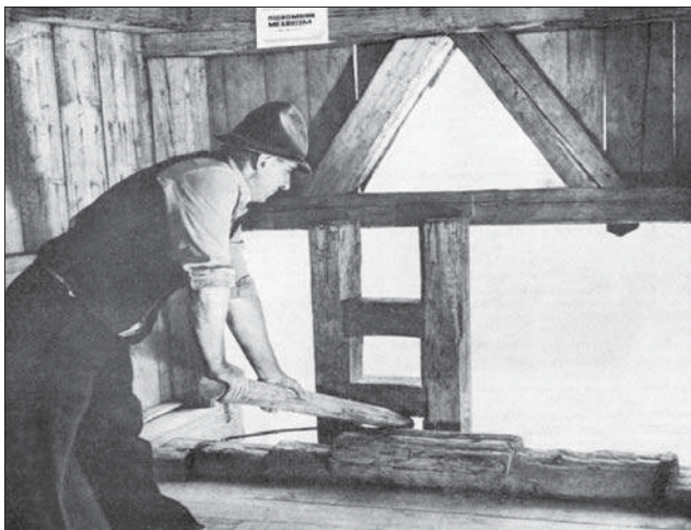
Рис. 2.15. Екскурсовод І.Д. Іваніна демонструє механізм підняття воріт для пуску води. Фото з путівника «Музей лісу і сплаву» Я.М. Байрак, Д.Е. Матола. 1987 р.
