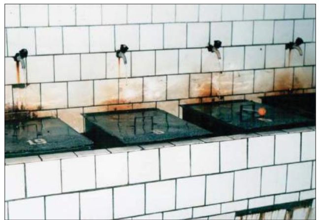
Рис. 2.37. Внутрішній вигляд форелеінкубатора. Фото з архіву НПП «Синевир». 1985 р.
