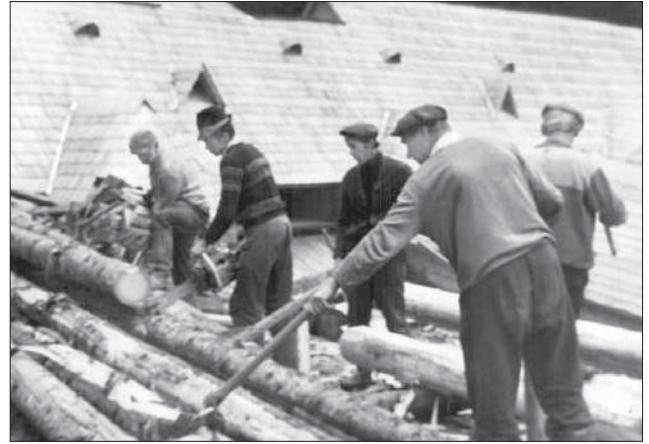
Рис. 2.20. Будівельна бригада на реконструкції греблі. Фото з архіву НПП «Синевир». 1988 р.
