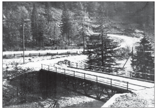
Рис. 2.71. Автомобільний міст через Теремлю. Фото з архіву НПП «Синевир», 1998 р.
