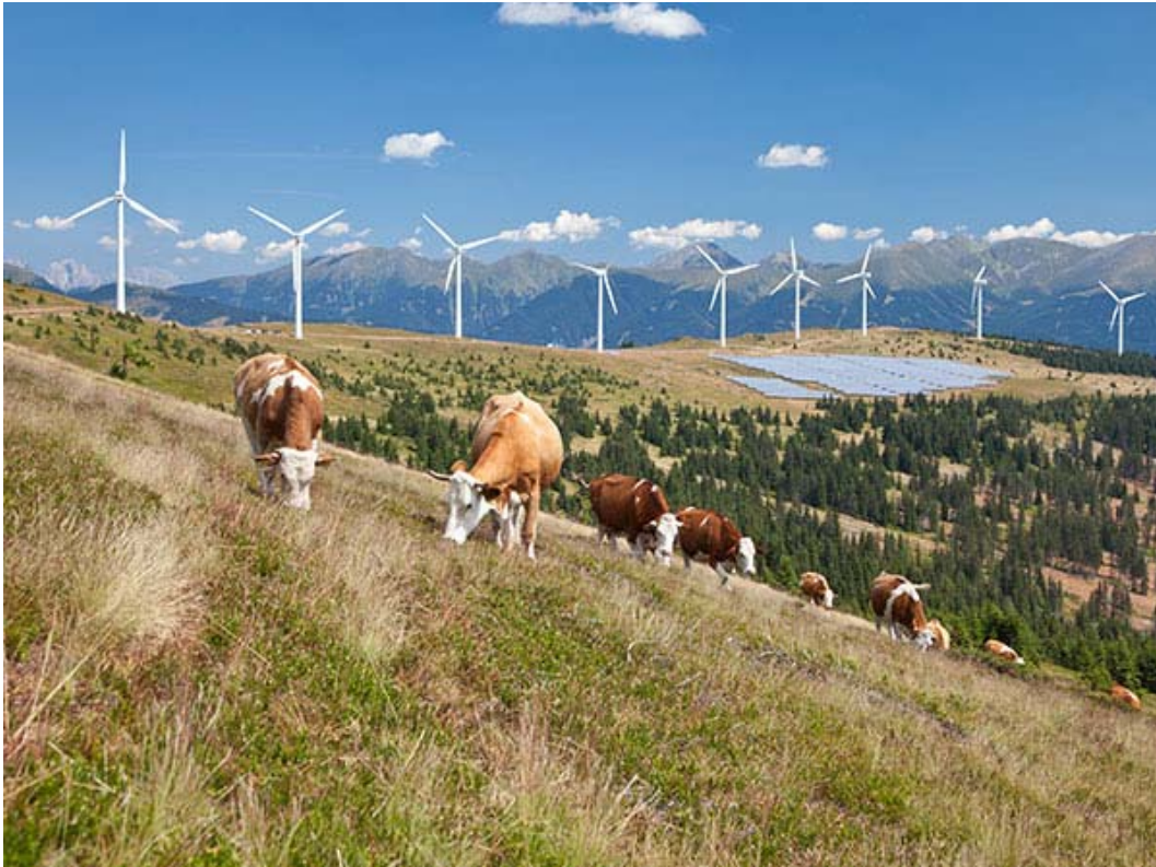
Рис. 6. Вид на ВЕУ вітроелектростанції Тауернвіндпарк - однієї з найвищих у Європі, яка працює на висоті 1900 метрів над рівнем моря, розташованої у гірському масиві Нідере Тауерн в Штирії, Австрія [ https://www.cleanenergyworld.net/scaling-heights-vestas-repowers-one-of-europes-highest-located-wind-parks.html ], у подібних інженерно-геологічних та гідрогеологічних умовах до проєктованої вітроелектростанції 120 МВт у Західній частині Полонини Боржава
