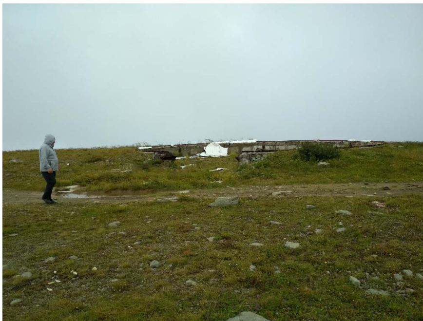
Рис. 2. Ділянка під ВЕУ на г. Стій у Свлявському районі поблизу зруйнованої будівлі радара колишньої військової частини
