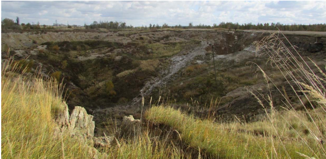
Рис. 2. Провал на пласті № 10 Пд-Сх рудника № 2 Стебницького ГХП «Полімінерал» в районі камер № 108-109-110-111-112-113, який стався 30 вересня 2017 року, 0 годин 46 хвилин
