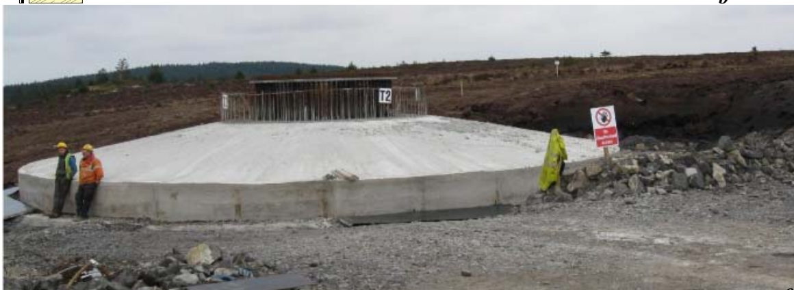
Рис. 7. Мінімумна глибина закладення котловану для влаштування плитного фундаменту ВЕУ № 6 на горизонтальній поверхні (3,5 м) – a, максимумна глибина для ВЕУ № 9 на крутосхилі (8 м з одного боку та 2-3 м з протилежного боку) – b, та вигляд типового плитного фундаменту під ВЕУ - c
