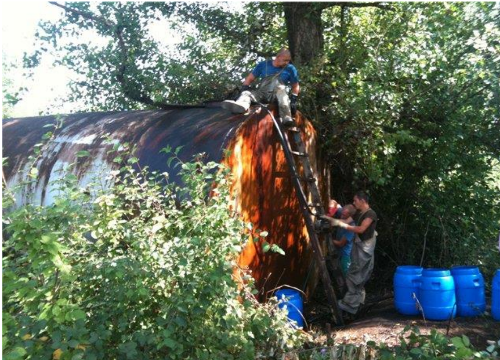
Рис. 4.11. Перепакування шкідливих речовин з цистерни у пластикові бочки для відправлення на утилізацію.
