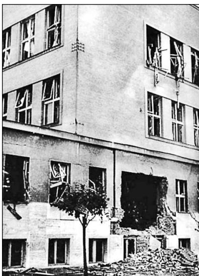
Будівля пошти у Кошице після «радянського бомбардування» 26 червня 1941 р., що стало формальним приводом для вступу Угорщини у війну проти СРСР
