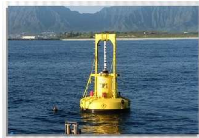
Рисунок 1 – Хвильовий енергетичний буй
