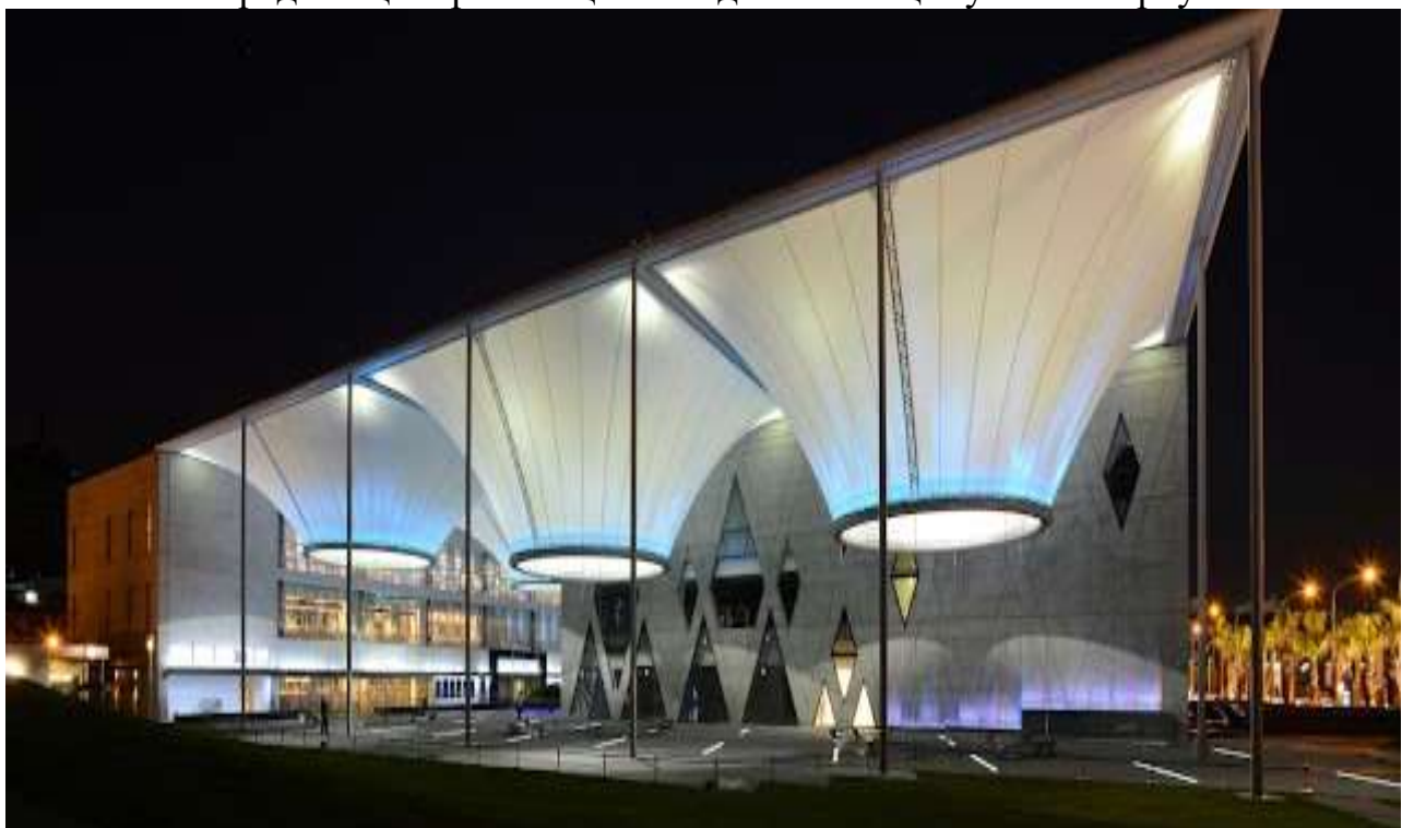
Рис. 2 Приклад вантово-натяжних (мембранних) конструкцій в архітектурному середовищі. Центр мистецтв у Тайвані.
