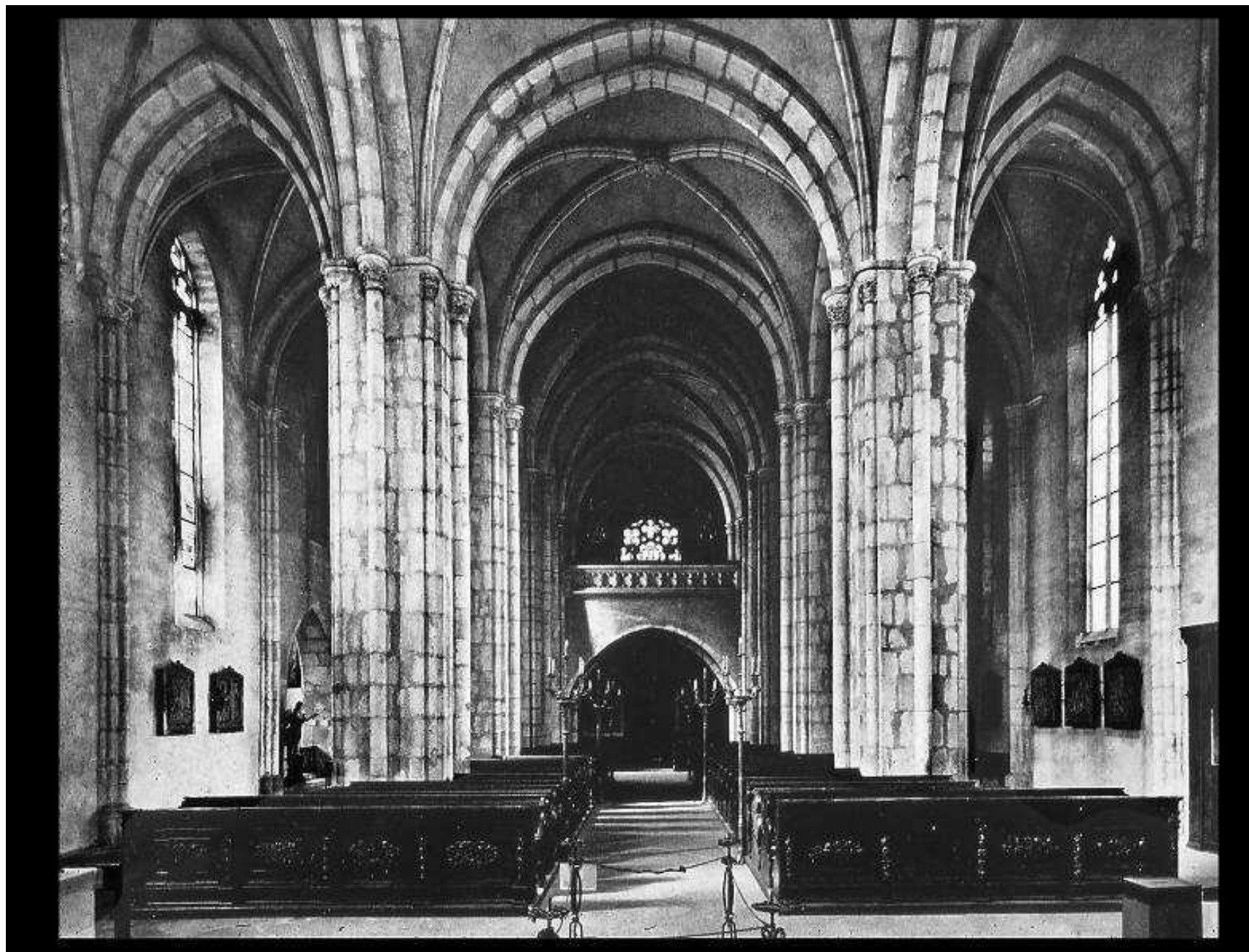
9. Kolín. Kostel sv. Bartoloměje. Pohled do síňového trojlodí (690.-70. léta 13. stol.).
