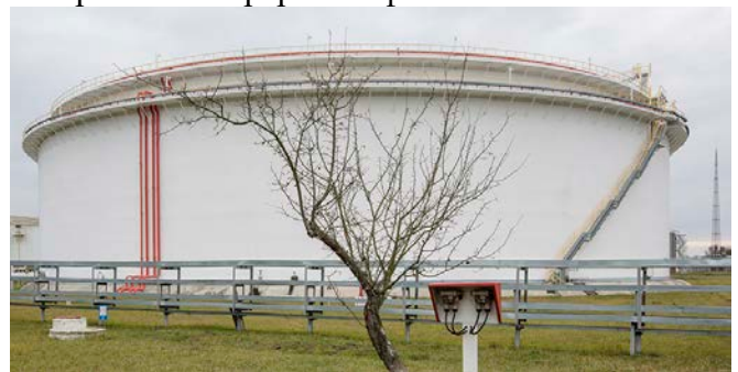
Рис. 1 Наземний вертикальний циліндричний сталевий зварний резервуар номінальною місткістю 75 000 м 3 з плаваючим дахом та подвійною стінкою підприємства ЛВДС «Броди»
