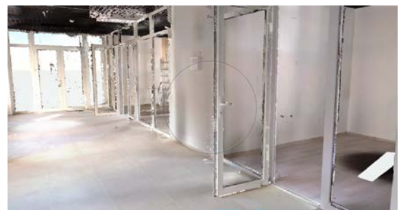
Рис. 5 Вигляд об'єкту реконструкції на завершальному етапі
