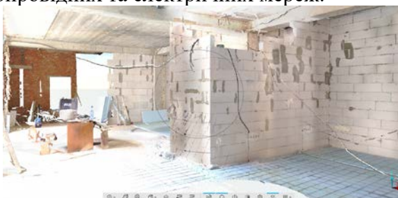
Рис. 4 Вигляд об'єкту реконструкції на етапі 2
