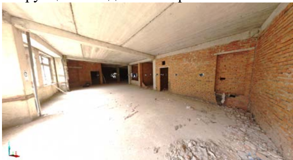
Рис. 3 Вигляд об'єкту реконструкції на етапі 1
