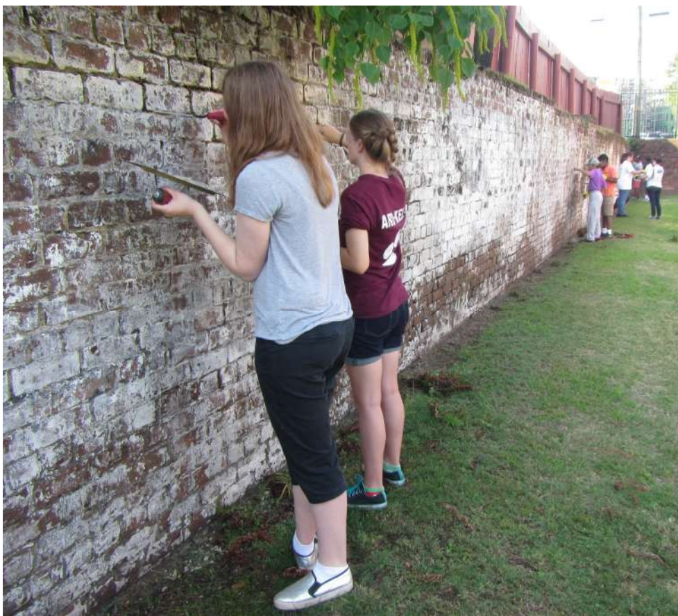
Рис. 8. Учасники літнього історичного лагера-2016 реставрують расшивку швов кладки пам'ятника архітектури ХІХ в. Фотографія автора
