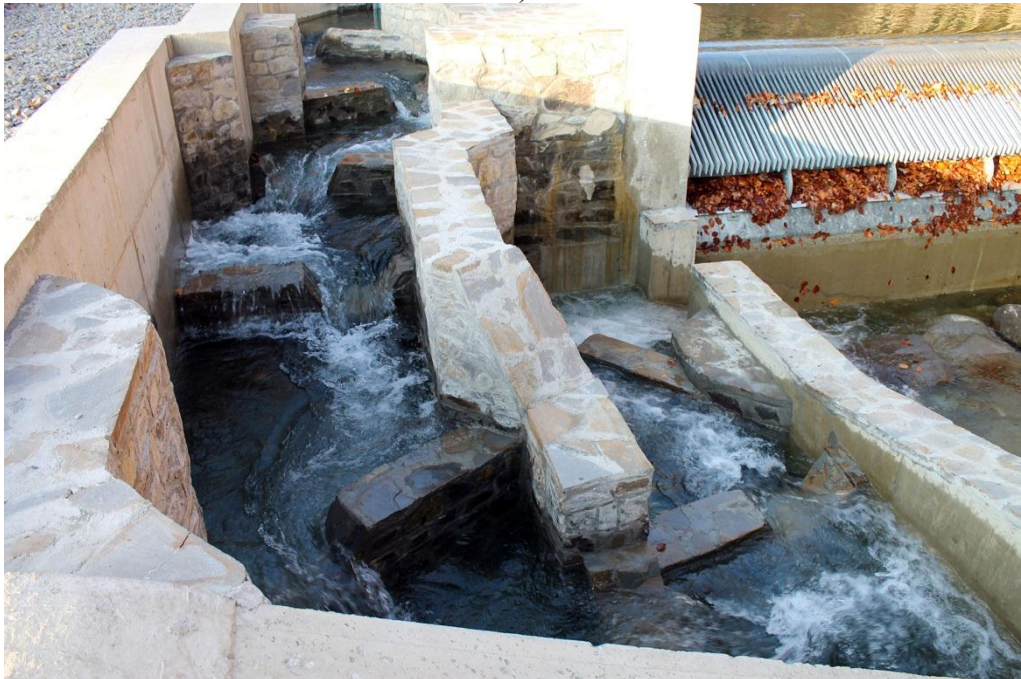
Рис.1. Тур'я-Полянська мала ГЕС (Шипот-2): а) будівля, в якій знаходиться турбіна; б) рибохід і на водозаборті та решітка через яку відбирається вода із водотоку[5].
