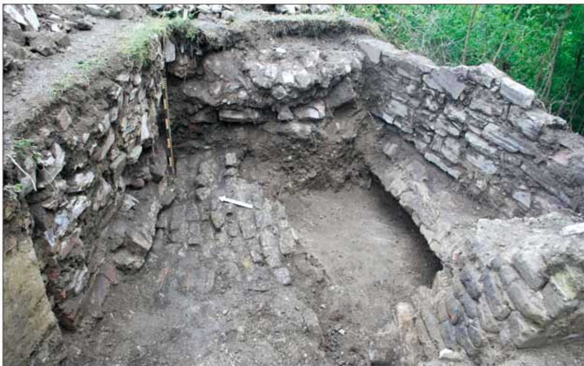
Рис. 7. Королёвский замок Нялаб. Раскоп I. Разрушенная арка.
