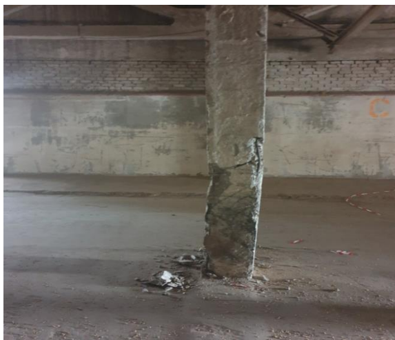
Рис. 1. Загальний вигляд руйнування залізобетонної колони середнього ряду
