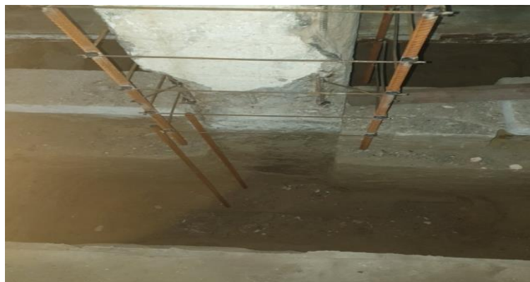
Рис. 3. Відновлення колони на рівні фундаменту
