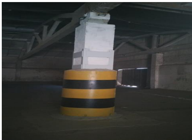
Рис. 4. Загальний вигляд відновленої залізобетонної колони з захисним обрамленням
