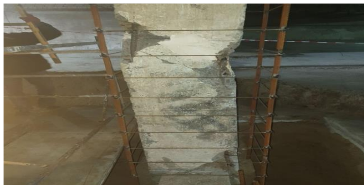
Рис. 2. Встановлення підготовленого каркасу
