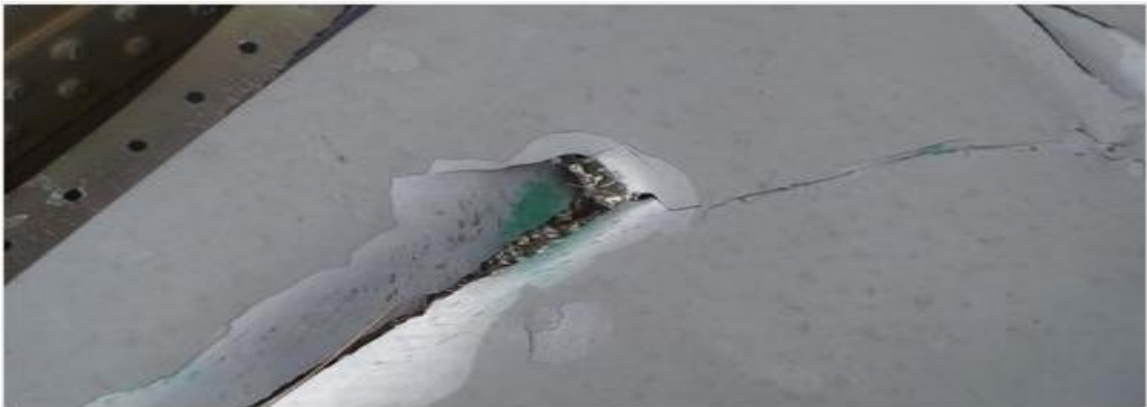
Рис. 1. Руйнування обшивки крила літака
