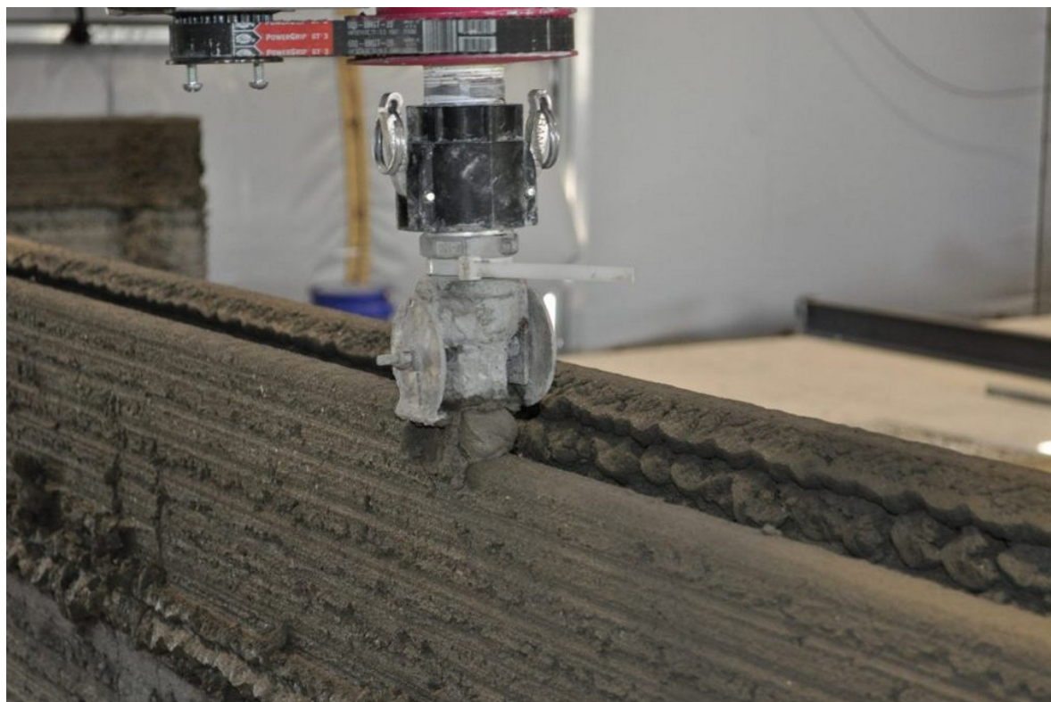
Мал.4. Укладання бетонної суміші за допомогою 3D принтера
