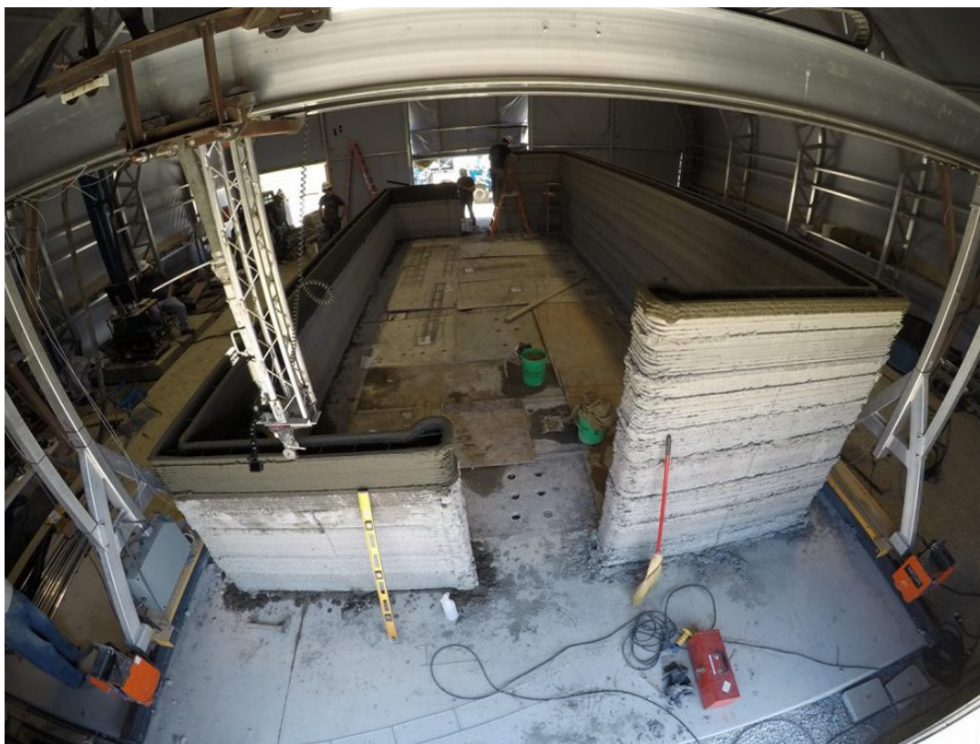
Мал.2. Процес роботи будівельного 3D принтера Джерело: all3dp.com.
