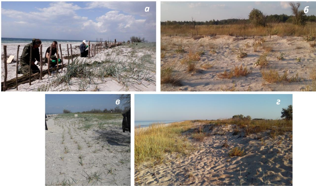
Рис. 2. Укріплення та відновлення еолових форм рельєфу в межах фронту Кінбурнського півострова: а – створення бар'єру з щитків (2013); б – стан щитків у 2019 році; в – висаджування саджанців (2013); з – стан закріпленої ділянки у 2019 році.
