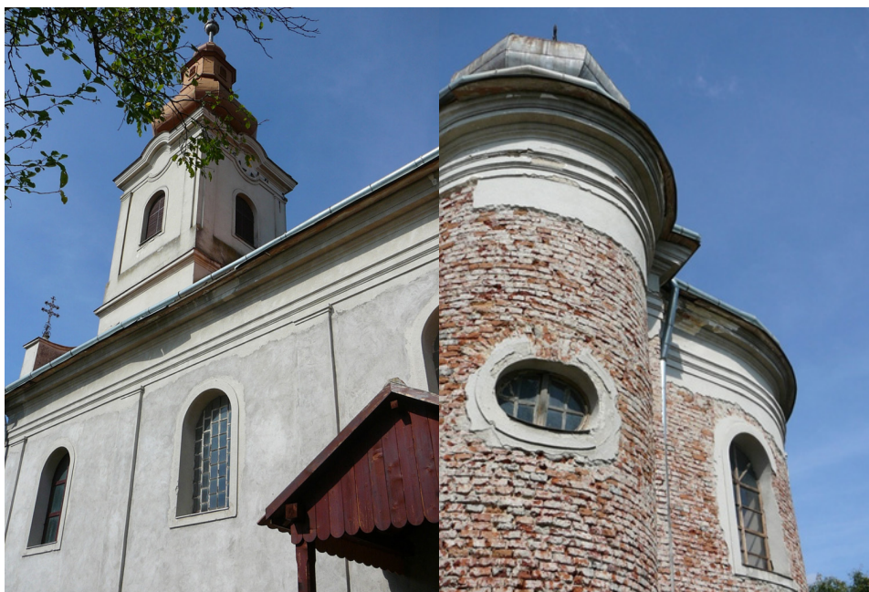
Peretele sudic al navei, cu porticul din fața ușii de acces
