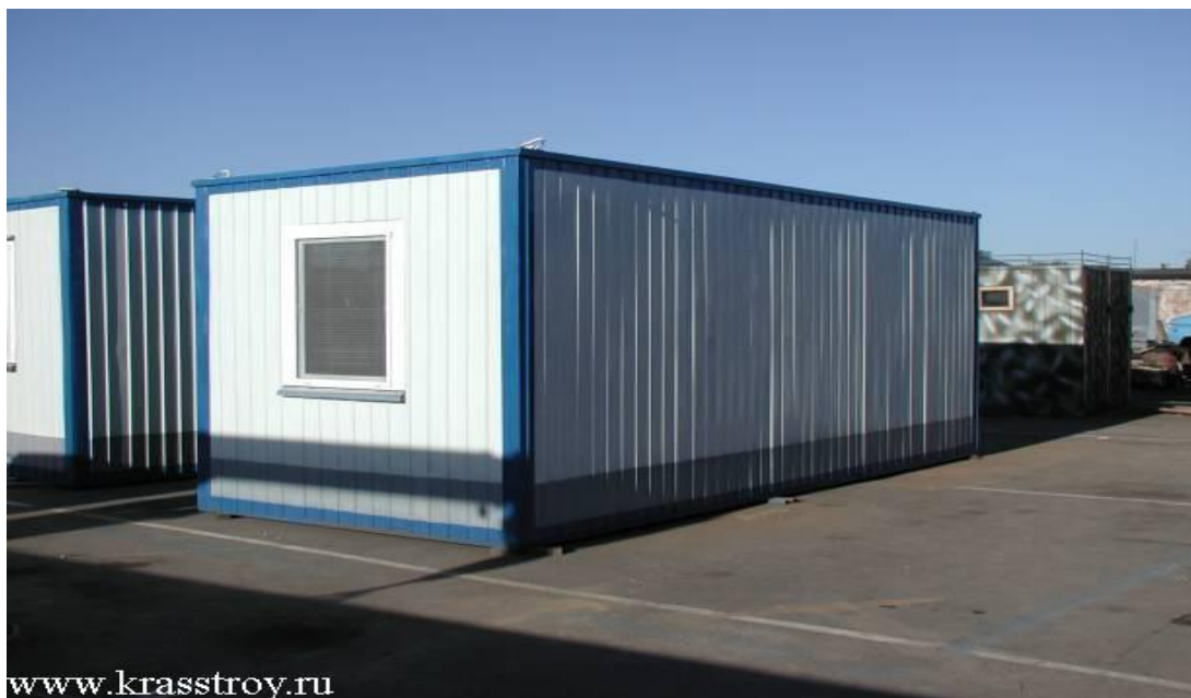
Мал. 4. Модуль вагончик - підключено електроенергію, а також підведено всі комунікації: каналізацію і водогін.
