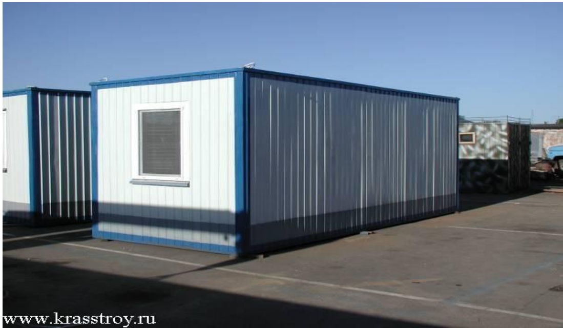
Мал. 4. Модуль вагончик - підключено електроенергію, а також підведено всі комунікації: каналізацію і водогін.
