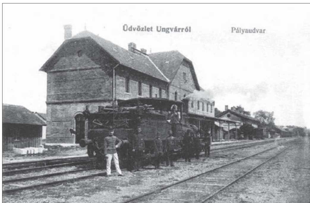
Залізничний вокзал і станція в Ужгороді, збудовані в кінці XIX ст. [5].
