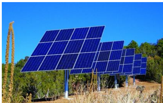
Рис. 1. Встановлення сонячних панелей на землі
