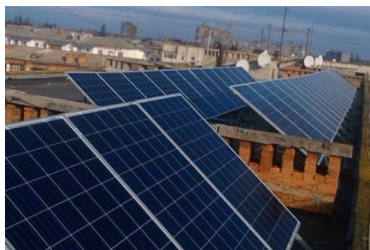
Рис. 2. Встановлення сонячних панелей на плоскому даху
