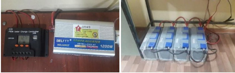
Рис. 1 Комплект устройств фотоэлектрического преобразователя (4 панели по 200 Вт)
