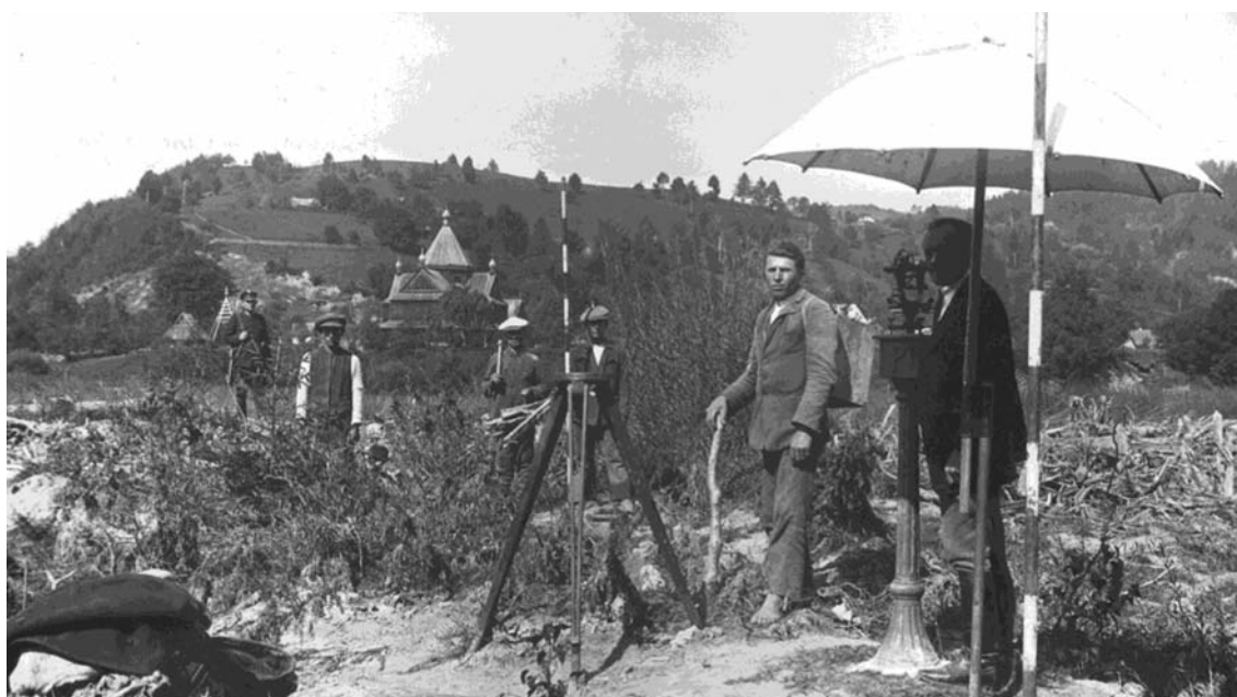
ródło: Narodowe Archiwum Cyfrowe (NAC), Wytyczanie granicy polsko-rumuńskiej — prace geodezyjne związane z wyznaczaniem kątów. Widoczna aparatura pomiarowa, 1929 r., sygnatura: 1-H-536-1.
