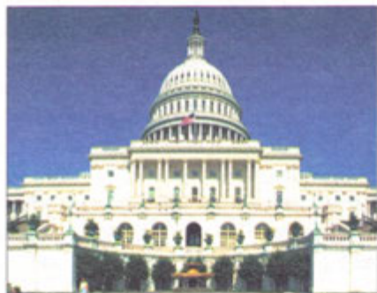
Будинок Конгресу в м. Вашингтоні. Сучасне фото
