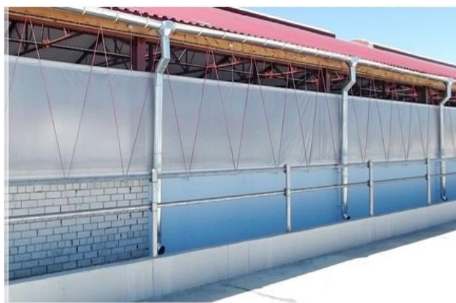
Рис. 1. Система вентиляционных штор
