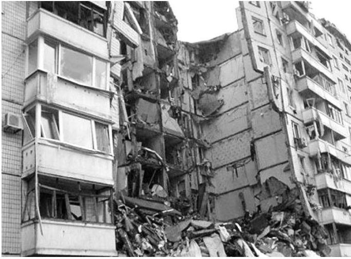
Мал. 127. Руйнація багатоповерхового житлового будинку в м. Дніпро внаслідок витікання газу і вибуху суміші.
