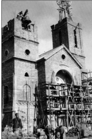
Будівництво доробратівської церкви, 1943 рік. Власний архів Михайла Садохи
