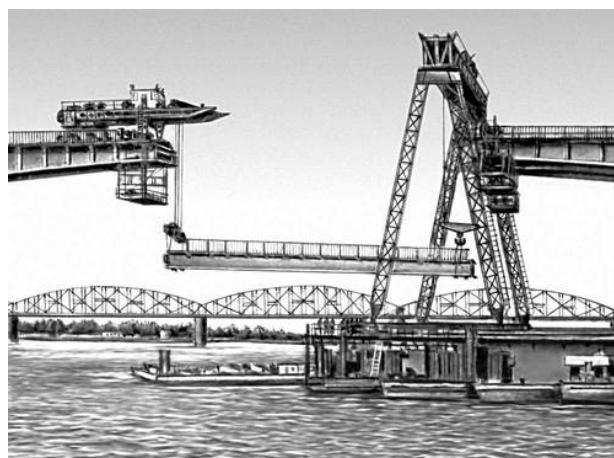
Рис. 2.13 Навісний метод монтажу рамного моста
