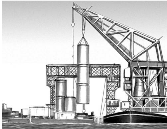
Рис.2.12 Занурення опор - залізобетонних оболонки на будівництві моста
