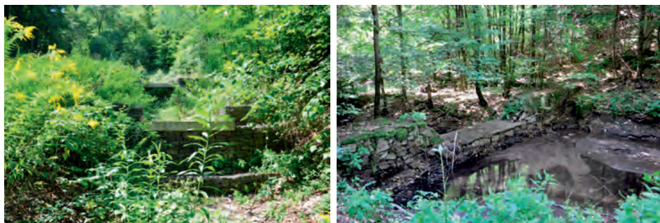
Рис. 9.10. Каскад загат у лісових ярах, які є наслідком ерозії ґрунту, та у тимчасових потоках у Словаччині (фото автора)
