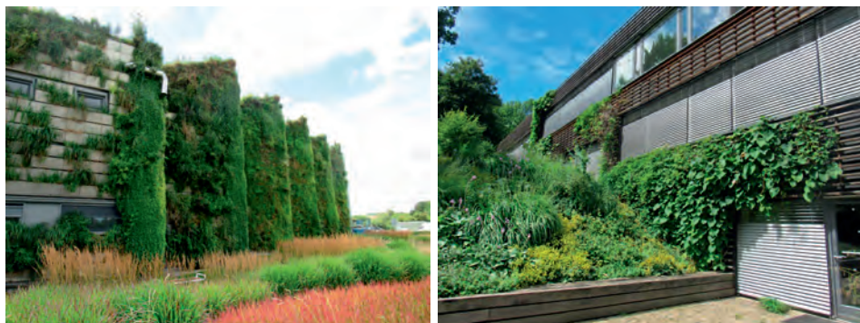
Рис. 9.2. Екстенсивний та інтенсивний зелений фасад у м. Брно, Чехія (Фото автора)
