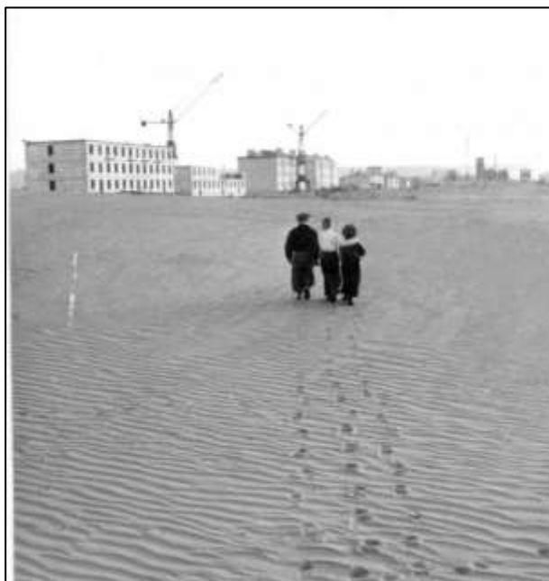
Рисунок 1.55 – Будівництво на сипучих пісках
