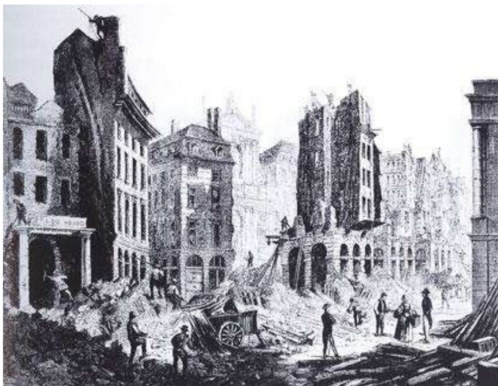
Початок робіт з реконструкції Парижа. Прокладання Севастопольського бульвару. Цей бульвар – один з перших, які були прокладені в епоху Другої імперії, – потребував знесення безлічі будівель. Стара гравюра
