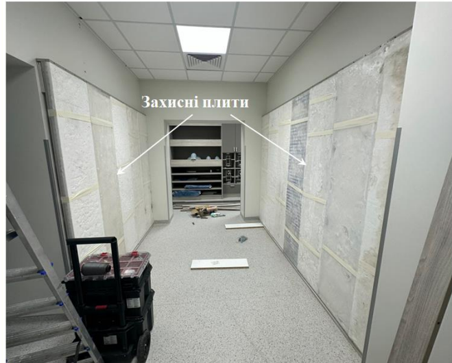
Рис.1. MCNP модель бункера і захисні плити всередині лабіринту
